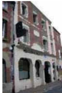
*La composition de la devanture doit suivre le rythme des immeubles et l'ordonnement des façades, en alignant les parties vitrées dans l'axe des baies situées aux étages et en respectant les trumeaux (pan de mur entre 2 baies au même niveau). Conserver les piliers d'angle, les bandeaux apparents et autres modénatures qui habillent la façade entre 2 niveaux. Dégager et conserver au rez-de-chaussée les structures porteuses de la façade.*
