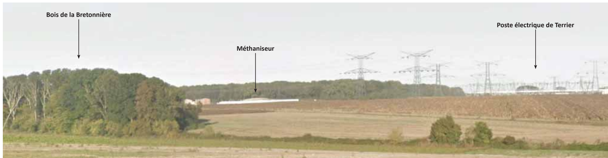
Vue sur le méthaniseur depuis le sud du territoire communal
