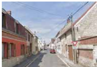
Rue du Mouthier dans le tissu bâti ancien, constructions à l'alignement
