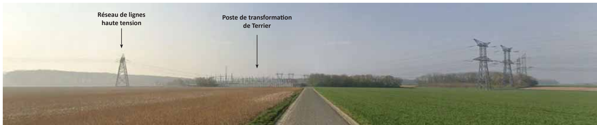
Vue sur le poste de Terrier depuis la route de Neuilly à Puiseux
